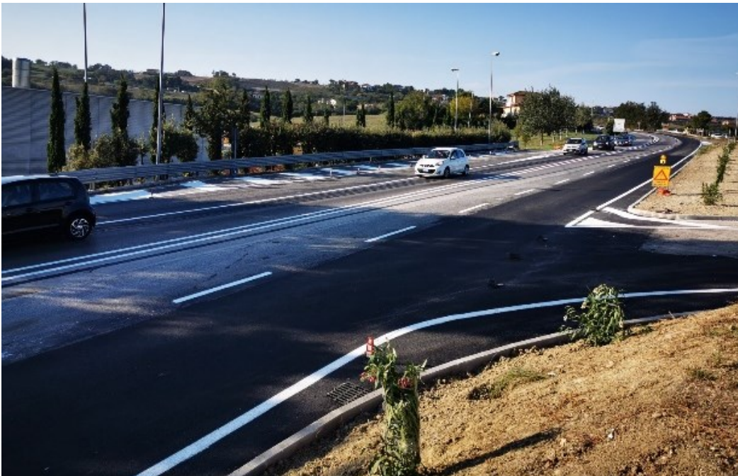
Corsia su via Conca ultimata direzione ovest
