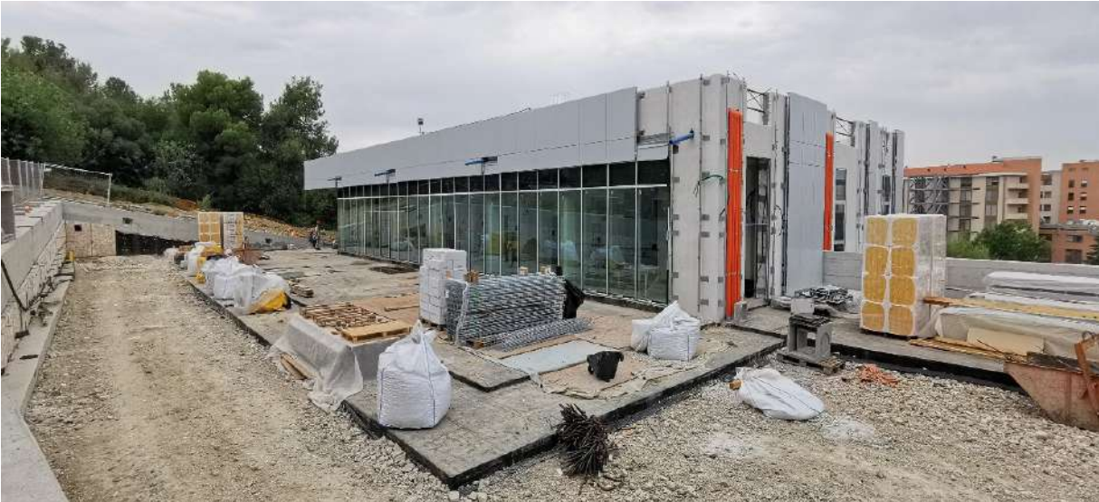
Nuova morgue in costruzione - Luglio 2021
