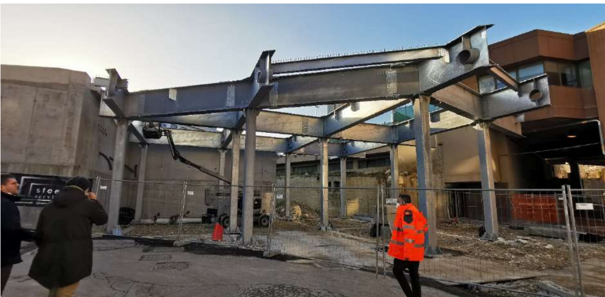
Nuova rampa camera calda – Gennaio 2022
