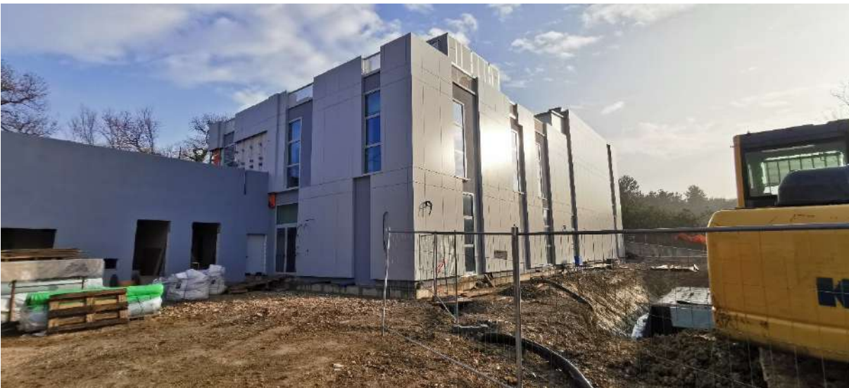
Nuova morgue in completamento – Gennaio 2022
