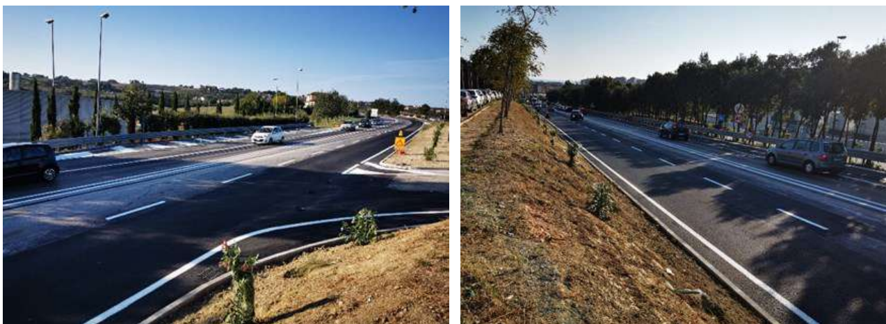
Corsia su via Conca ultimata (rispettivamente direzione ovest e direzione est) - Luglio 2021
