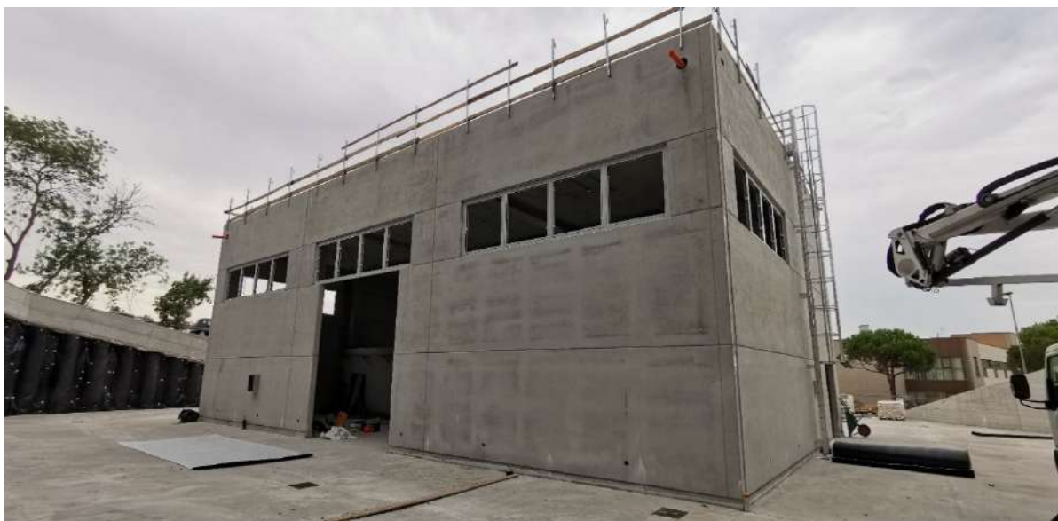
Nuova isola ecologica in costruzione - Luglio 2021
