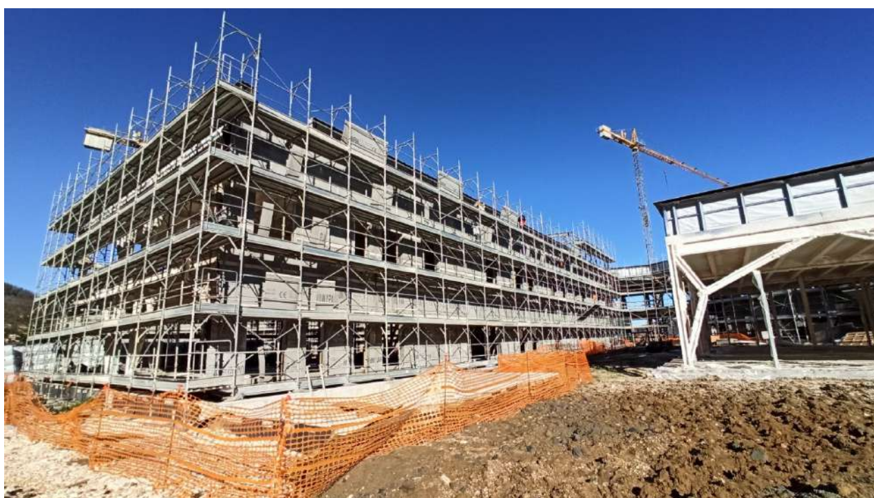
Montaggio struttura portante in acciaio – Luglio 2021
